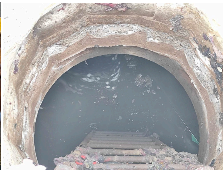
Будах үйлдвэрийн гадна газар доор байрлах технологийн устай 10тн худгийн байдал
