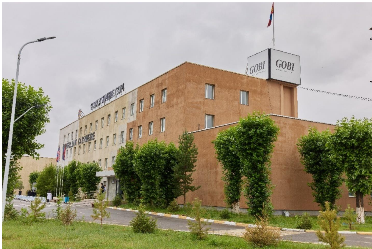
Зураг.2 Говь ХК-ийн үйлдвэрийн байр
