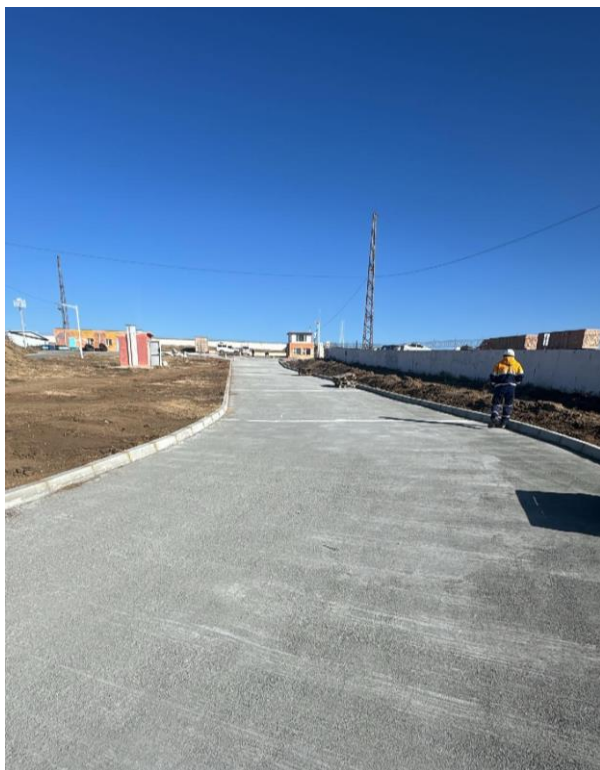
Зураг 3. Авто зам болон түүхий эдийн талбайг бетондсон байдал
