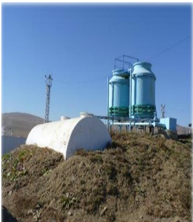
Үйлдвэрийн эргэлтийн усны сав, багтаамж - 200 м3
