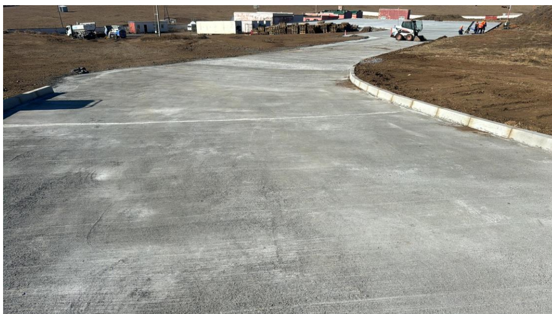
Зураг 3. Авто зам болон түүхий эдийн талбайг бетондсон байдал
