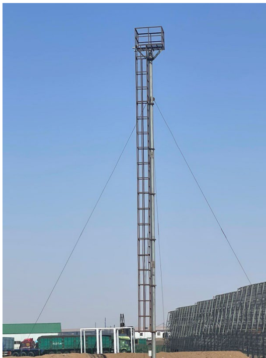
Зураг 6. 20 метр өндөртэй 2 ширхэг суурилуулсан гэрэлтүүлэг, камер бүхий Мобинетийн антен
