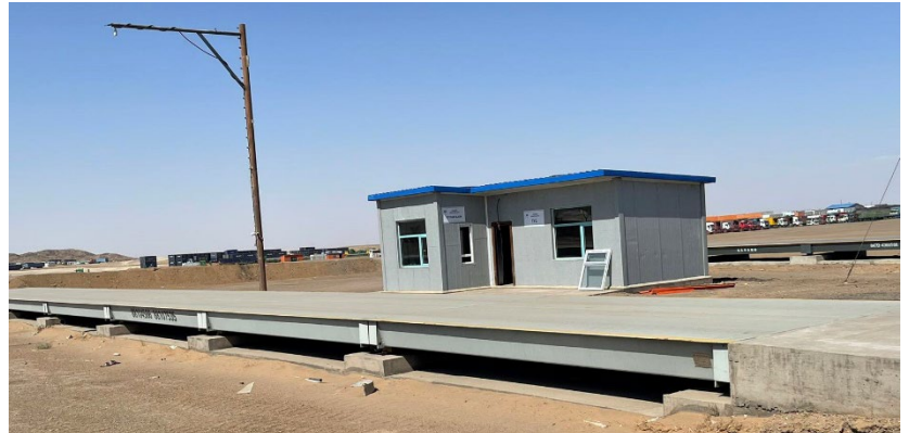
Зураг 5. Гаалийн хяналтын талбайд байрлуулсан 200 тонны цахилгаан пүү
