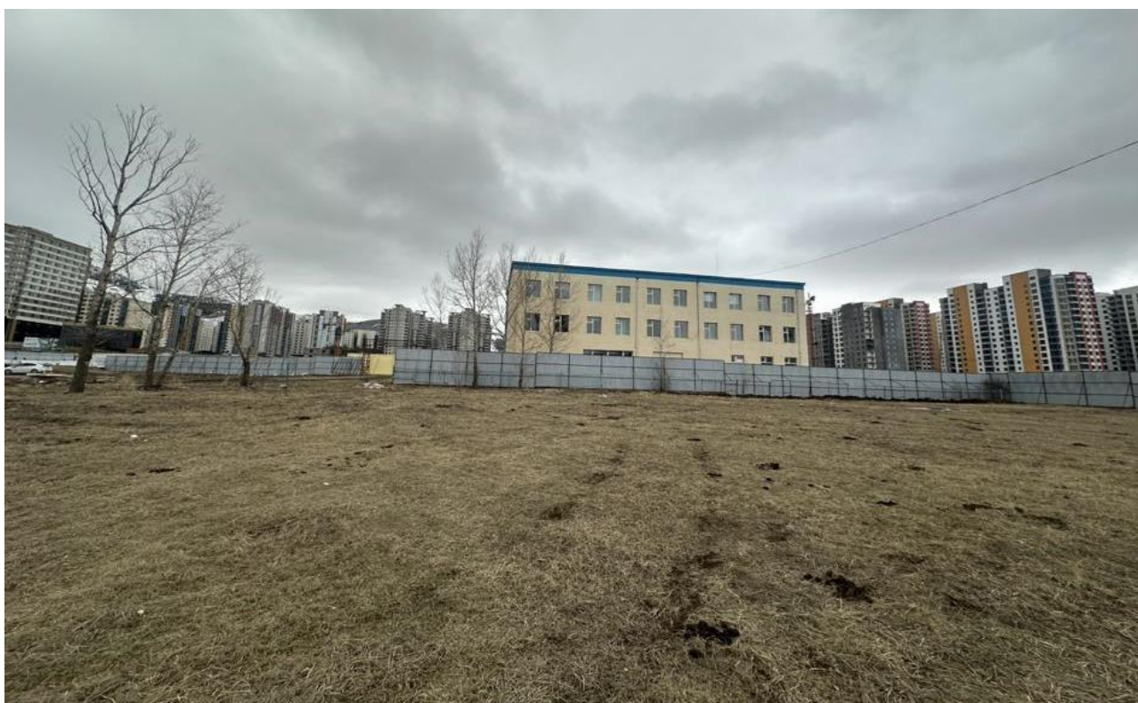
Зураг 4. Барилгажих талбай
