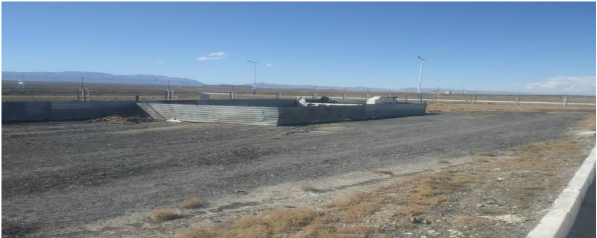
Нисэх буудал хог хаягдал, үнс нурмаа тээвэрлэн асгасны дараах байдал.
