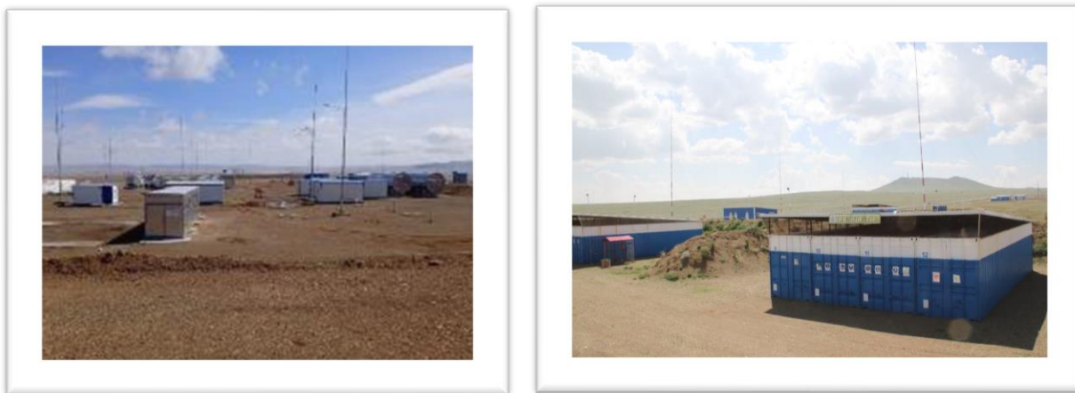
Зураг 12. Үйлдвэр агуулахын цогцолбор харагдах байдал
