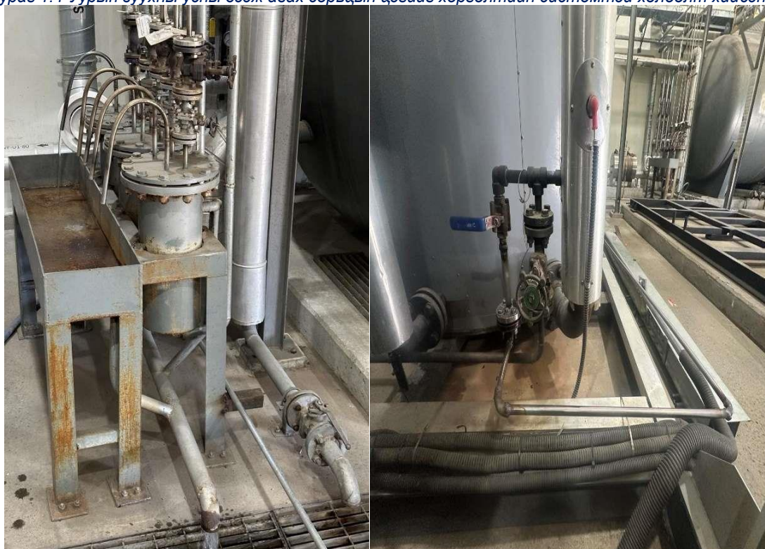
Зураг 1.4 Уурын зуухны усны дээж авах сорьцын цэгийг хөргөлтийн системтэй холболт хийсэн байдал
