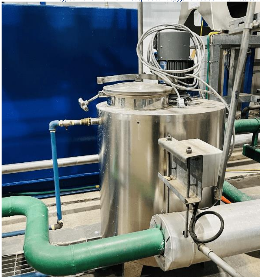
Зураг 1.4 Уурын зуухны усны дээж авах сорьцын цэгийг хөргөлтийн системтэй холболт хийсэн байдал
