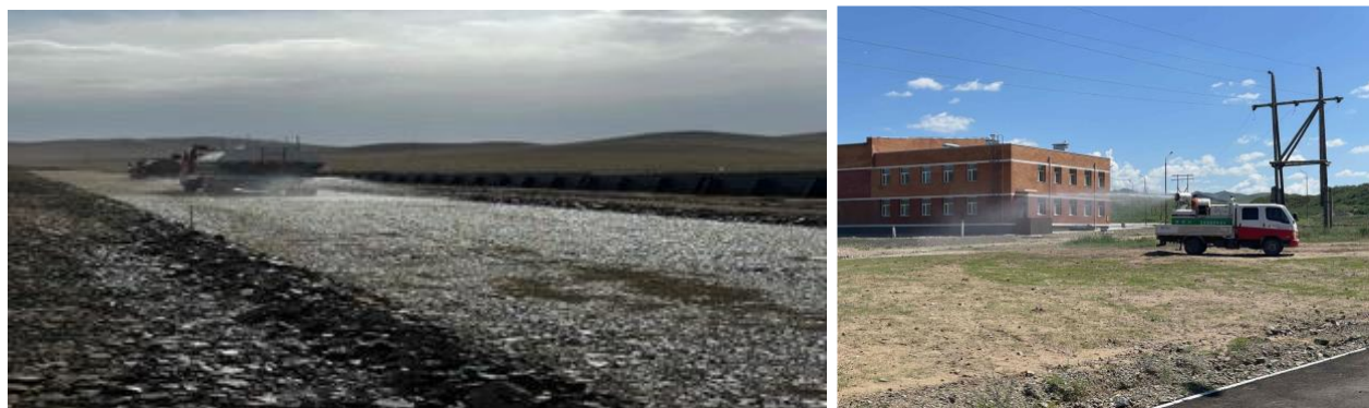
Зураг 6. Тоосжилт дарах талбайн усалгаа хийх явц
