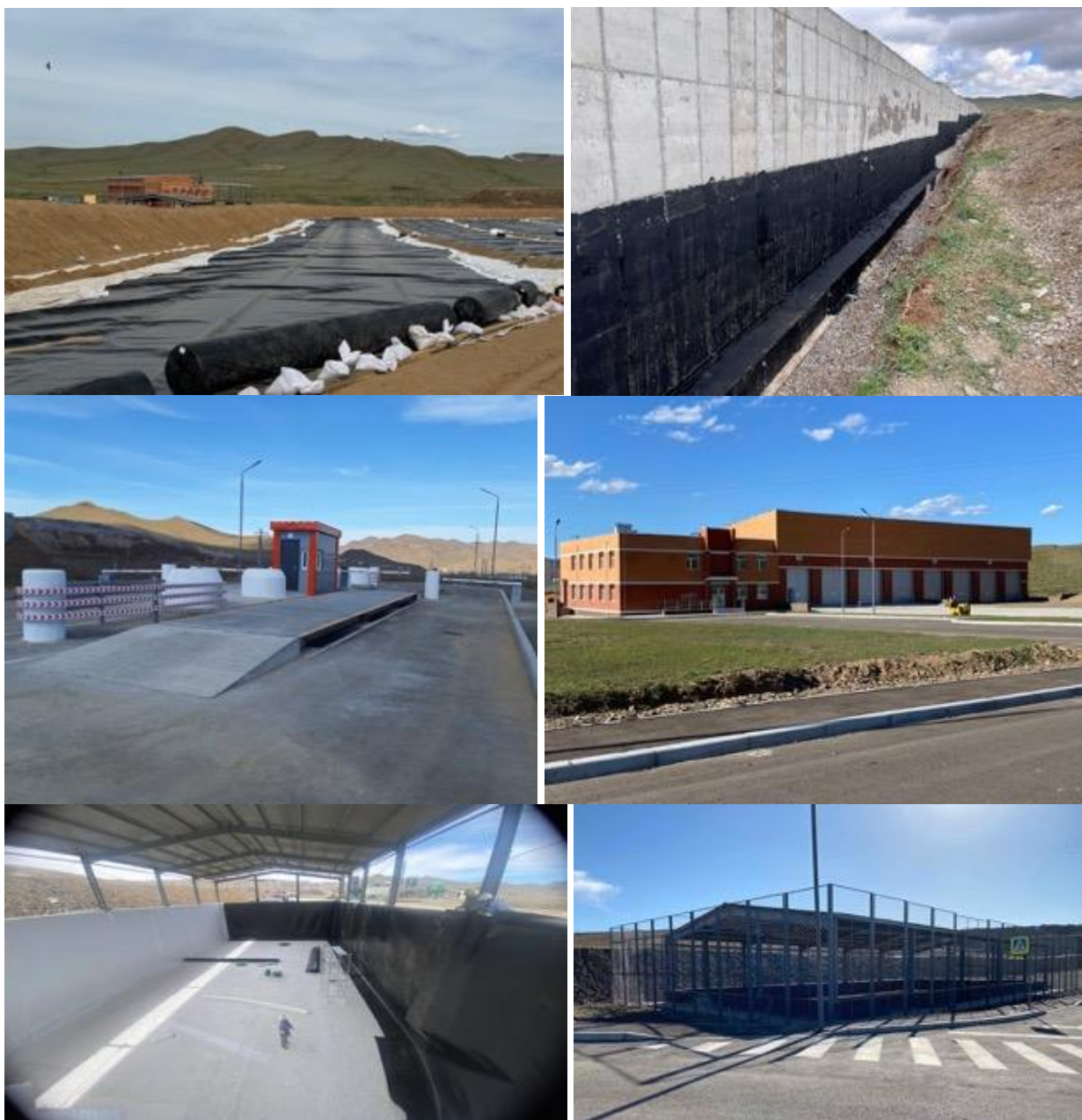
Зураг 3. Хатуу хог хаягдал ангилан ялгах ландфилл байгууламжийн төмөр бетон суурь, шүүрэл хадгалах байгууламж, оффис зэрэг барилгын ажлын явц
