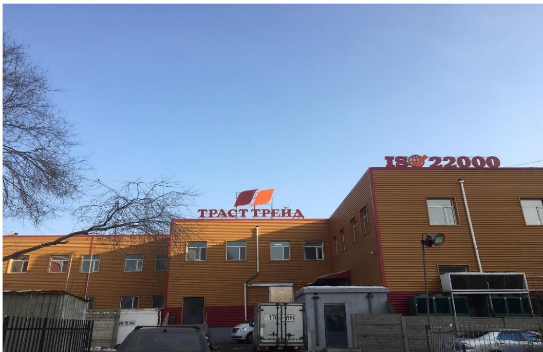
Зураг 2 Үйлдвэрийн гадна байдал
