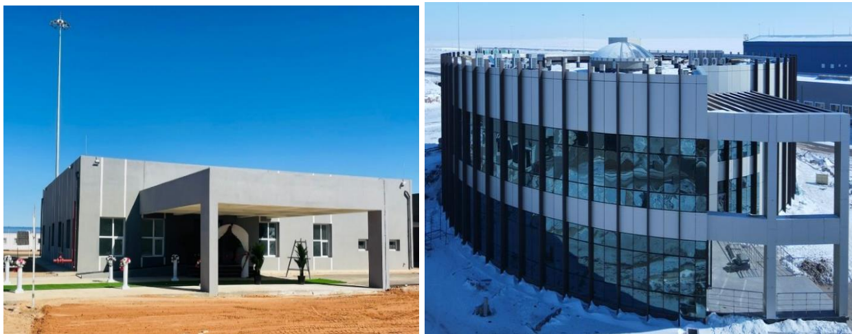
Зураг 9: Газрын тосны үйлдвэрийн хотхоны ажлын явц
