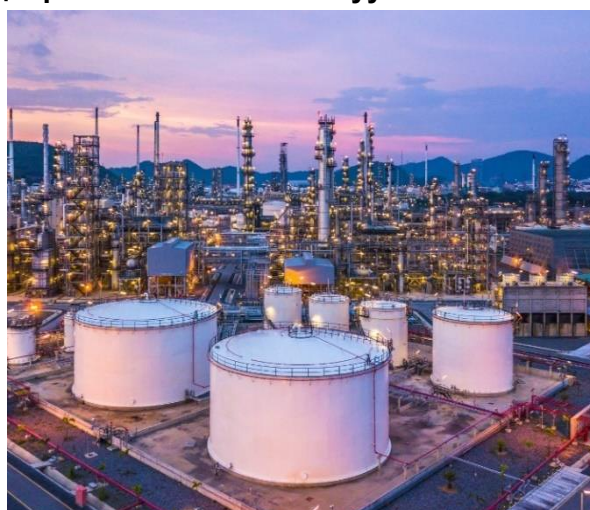
АГУУЛАХ САВ, РЕЗЕРВАРУУД
