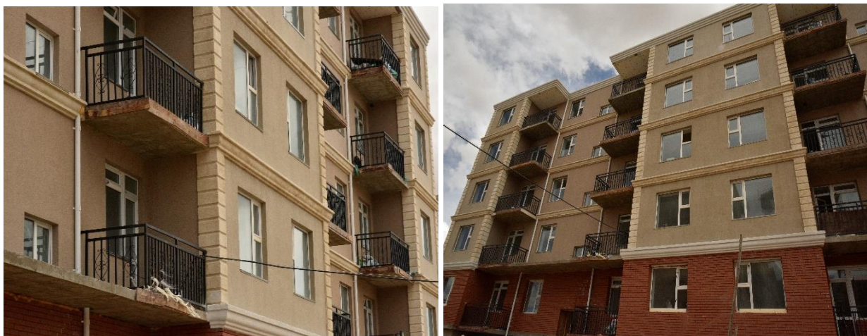
Зураг 8: Газрын тосны үйлдвэрийн хотхоны ажлын явц
