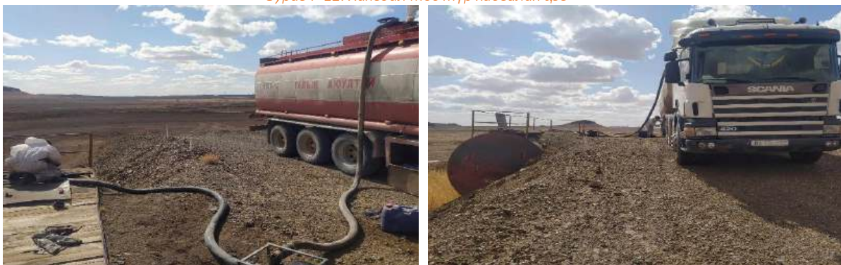
Зураг 7-13. Хаягдал тос шилжүүлж буй байдал
