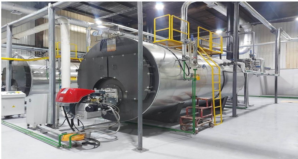
Зураг 1-7-1 Итали улсын RLS-610 маркын ноцоогуур ба тэжээлийн 2 системтэй. LPG (Liquefied petroleum gas/Шингэрүүлсэн нефтийн хий) болон Diesel (Түлш)
