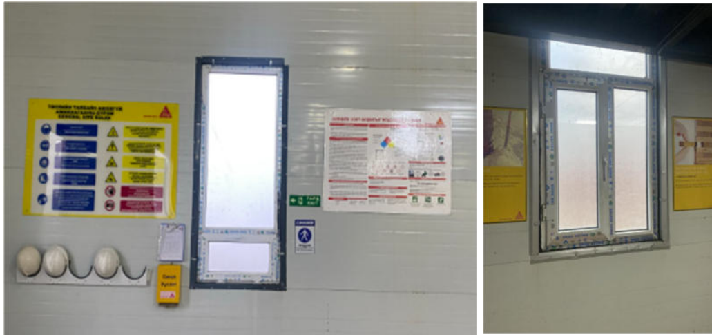
Зураг 3-2. Агуулахын цонхон нарны шууд тусгаарлах сүүн хуулга наасан байдал
