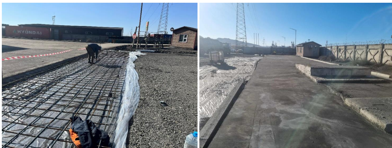
Зураг 8. Үйлдвэрийн зам талбайг бетондож хучилттай болгож буй байдал
