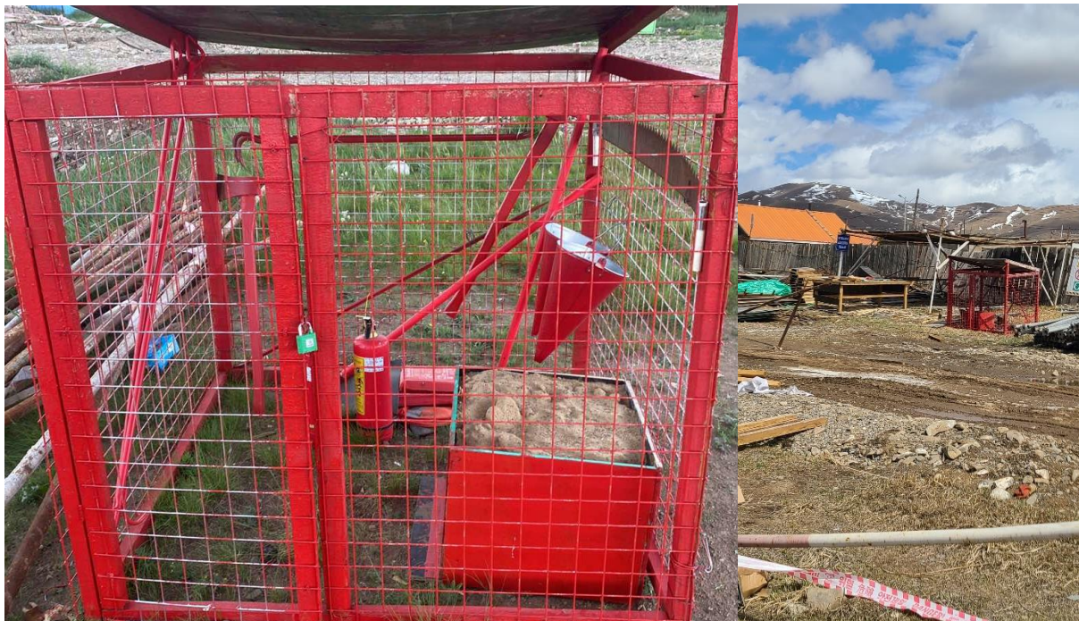
Зураг 6. Газар шорооны ажил явагдаж буй цэгт анхааруулах тэмдэг байрлуулан явган зорчигчийн хөдөлгөөнийг хязгаарлах арга хэмжээ авах
