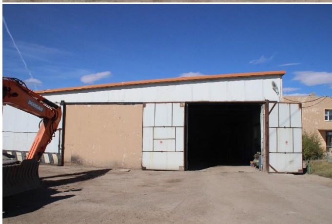
Зураг 4. Засварын газрын урд хэсгийг цементлэж хатуу хучилт хийсэн байдал
