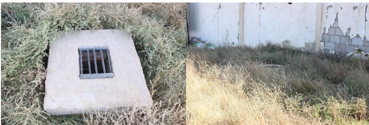
Зураг 17. Бохирын цооногийг цементлэсэн байдал
