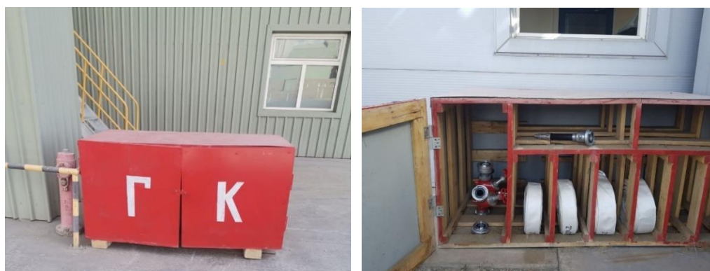
Зураг 30. Галын гидрантуудын ажиллагааг шалгаж бүрэн бүтэн байдлыг хангасан
