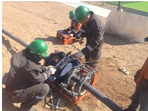
Зураг 12. Шугам сүлжээний засвар, угсралтын ажил гүйцэтгэж байгаа нь
