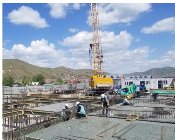
Ахуйн болон барилгын хог хаягдлыг хадгалах хог хаягдлын тусгай цэгийг барилгын талбайд байршуулсан. Хог хаягдлыг ялган ангилж хийхээр 3 төрлийн төмрөн хийцтэй хогийг савыг талбайд мөн байршуулсан.
