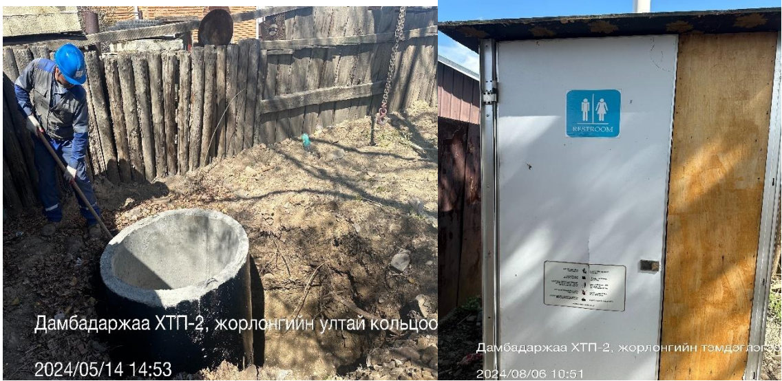
Зураг 73. ХТП-2 барилгын талбайд ултай кольцоог суулган ажилчдын түр жорлон байгуулав
