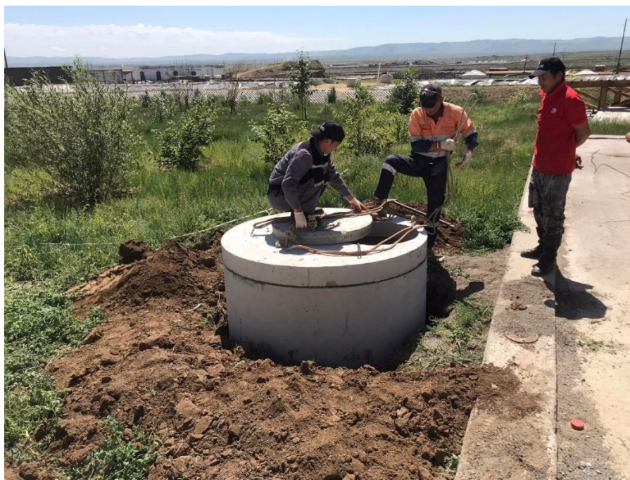
Зураг 34. Газрын доорх усны мониторингийн цооног байгуулж буй фото зураг №2
