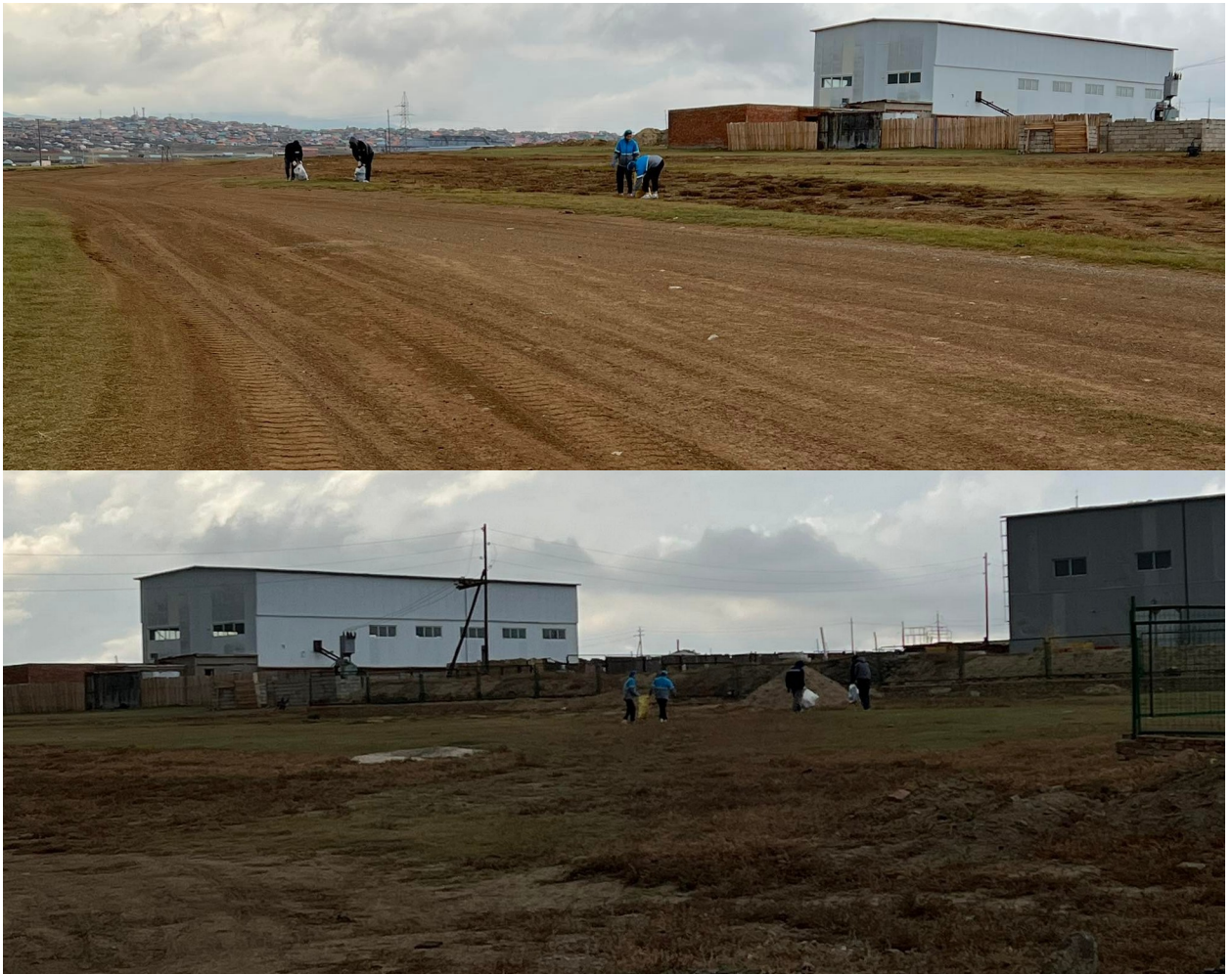
Зураг 28. Эрүүл мэндийн байгууллагын хог хаягдлын төвийн гадна талбайг цэвэрлэж буй фото зураг №2
