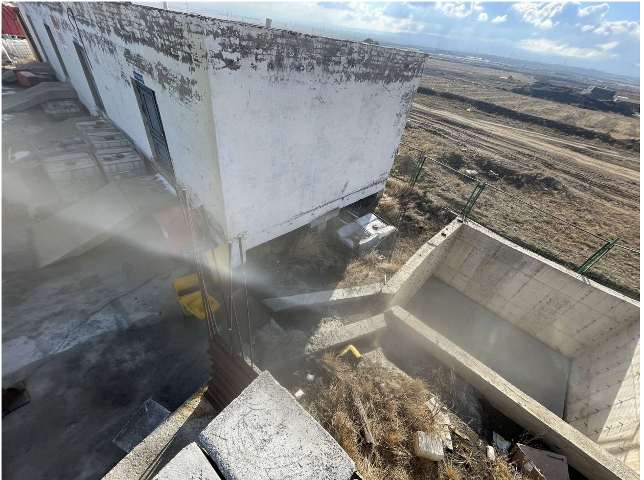
Зураг 29 Хатуу хучилттай талбайн борооны ус, асгаралтыг цуглуулах танк хийсэн фото зураг
