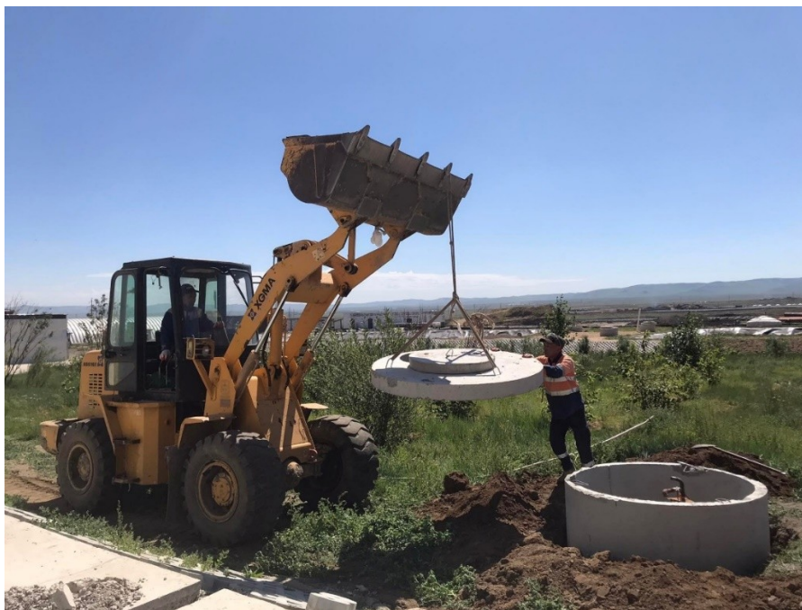
Зураг 33. Газрын доорх усны мониторингийн цооног байгуулж буй фото зураг №1
