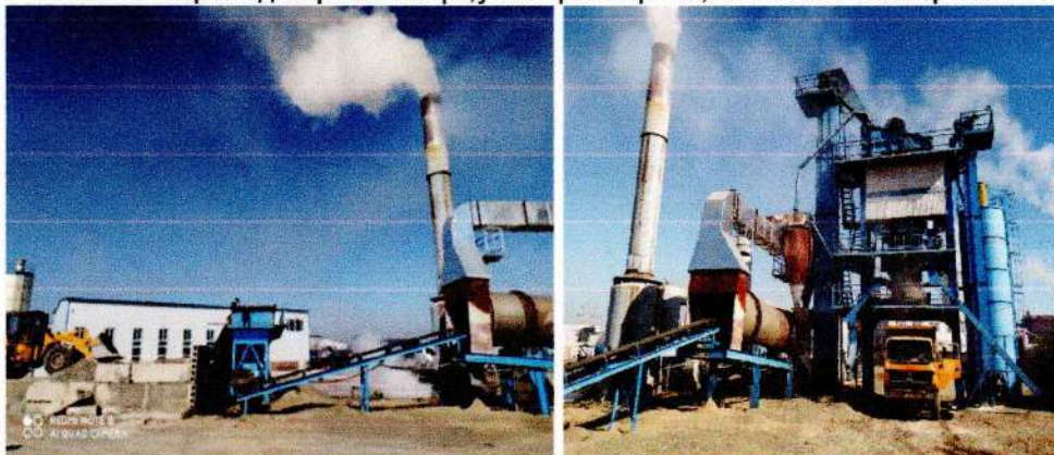
Зураг 5. Үйлдвэрийн тоног төхөөрөмж
