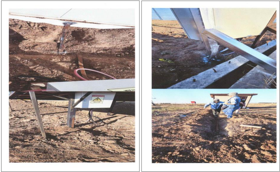
Зураг 43. Газардуулгын ажил гүйцэтгүүлж акт үйлдсэн байдал
