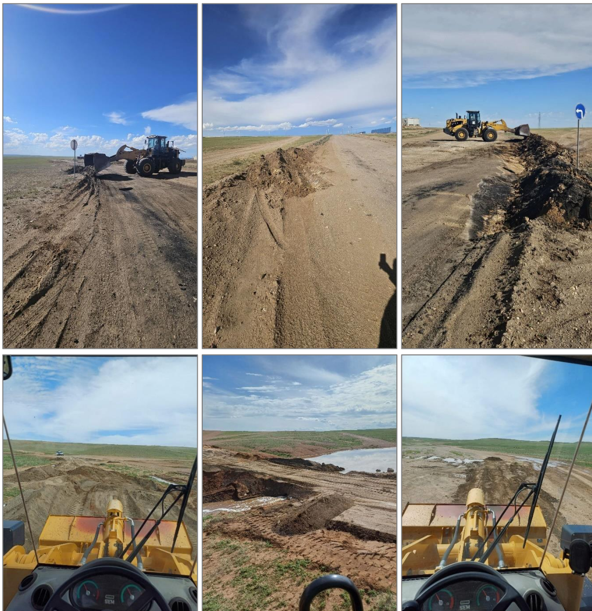
Зураг 69. Зам засварын ажил гүйцэтгэж буй явц
