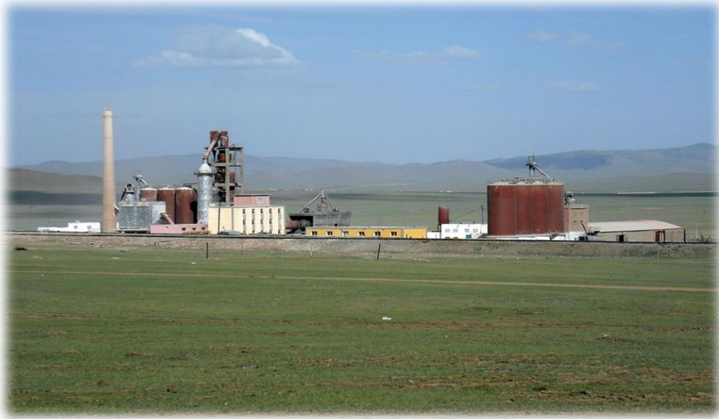
Зураг-1. “Налайх” цемент, шохойн үйлдвэрийн ерөнхий байдал
