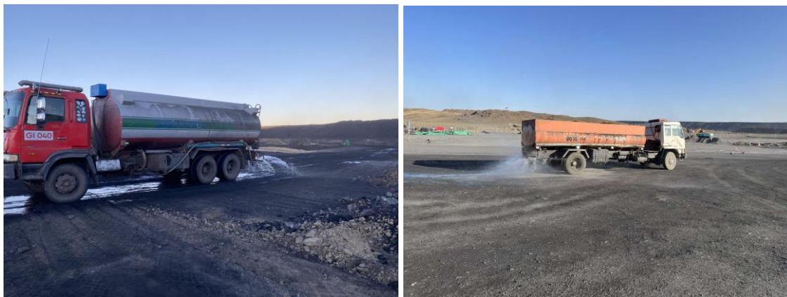
Зураг 2.1.3 - 2.1.6 Түр замын усалгаа, түр замын засвар арчилгаа хийж буй байдал
