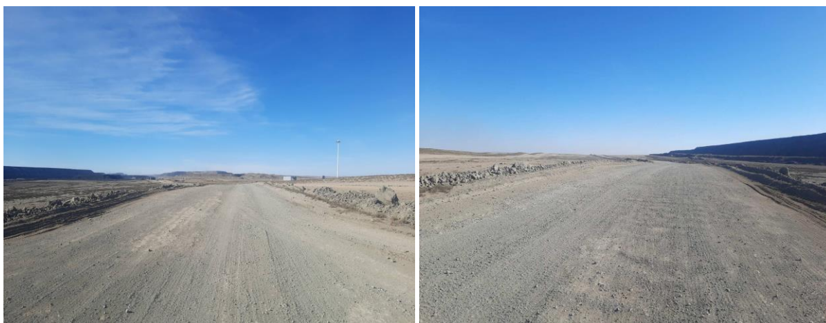
Зураг 2.2.1 2.2.2 Төсөл хэрэгжүүлэх талбай, барилгын ажилд ашиглагдах шороон замуудын маршрутыг тогтоож тэмдэгжүүлсэн.
