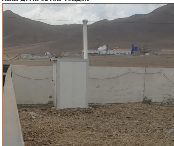
Ахуйн шингэн хог хаягдал зайлуулах цооног, соруулж зайлуулах зориулалт бүхий бие засах газар
