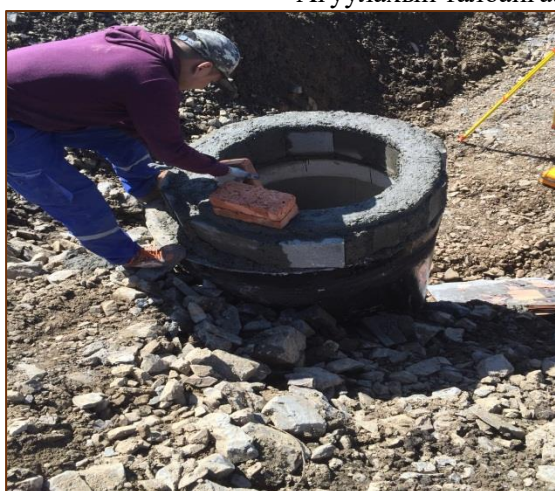
Ахуйн шингэн хог хаягдал зайлуулах цооног, соруулж зайлуулах зориулалт бүхий бие засах газар
