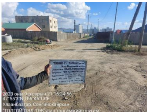
Цух.8-аас Цух.7 руу ф225мм хуванцар шугам угсралт хийж буцаан булж, нөхөн сэргээлт хийсэн байдал
