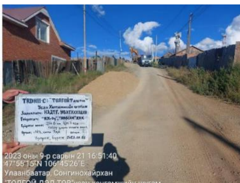
Цух.6-аас Цух.7 руу ф225мм хуванцар шугам угсралт хийж буцаан булж, нөхөн сэргээлт хийсэн байдал
