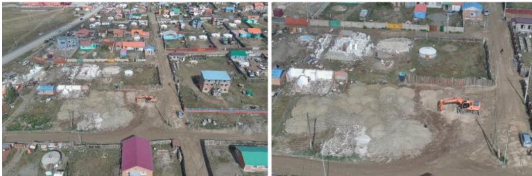
УХЛАГ-ын 1-р хэсэг, шороог механизмаар зөөвөрлөх, буцаан ачиж булалтыг хийсэн байдал
