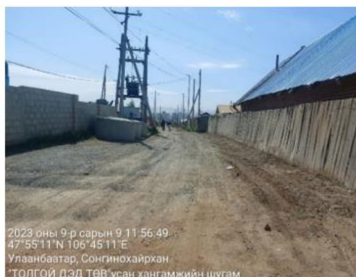
Цух.6-аас Цух.7 руу ф225мм хуванцар шугам угсралт хийж буцаан булж, нөхөн сэргээлт хийсэн байдал
