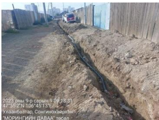
Цух.6-аас Цух.7 руу ф225мм хуванцар шугам угсралт хийж буцаан булж, нөхөн сэргээлт хийсэн байдал
