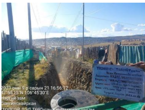
Цух.6-аас Цух.7 руу ф225мм хуванцар шугам угсралт хийж буцаан булж, нөхөн сэргээлт хийсэн байдал
