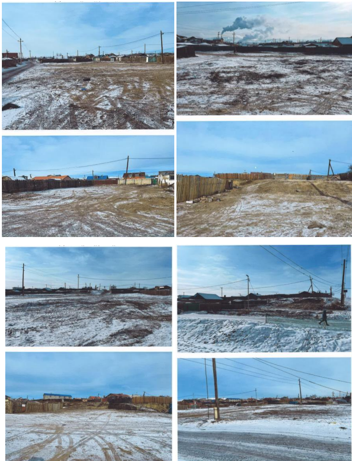
Газрын хэлбэржүүлэлт, тэгшилгээний ажил
