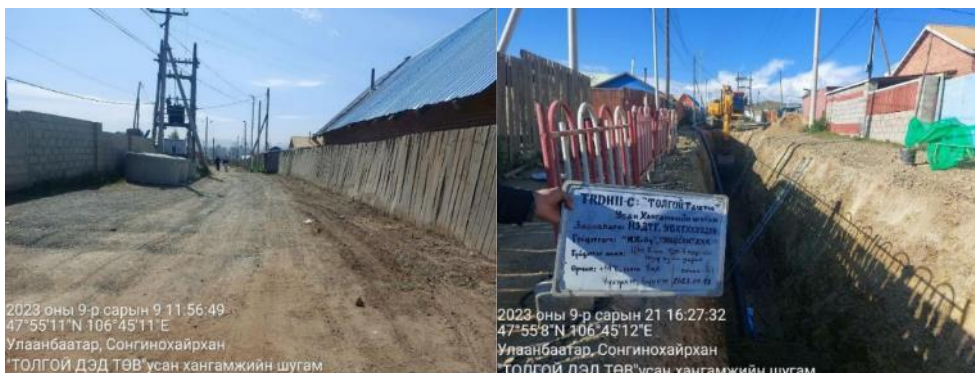
УХЛАГ-ын 2-р хэсэг, шороог нүхний хажууд овоолж, буцаан дарж булалт хийж нөхөн сэргээсэн байдал
