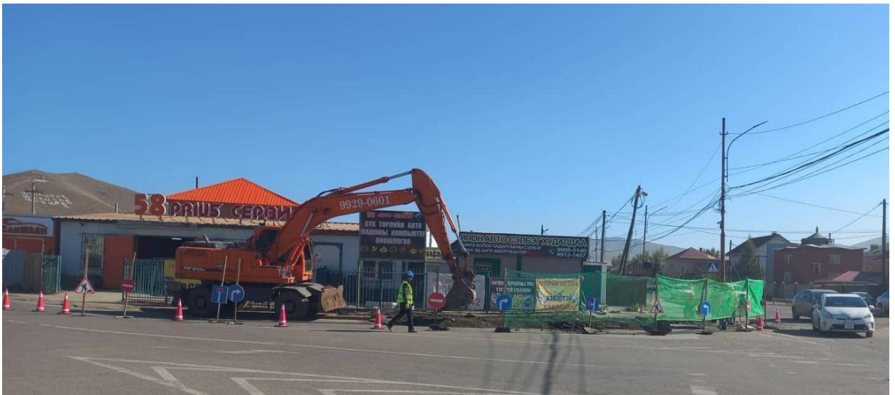
Зураг 5-2. Газар шорооны ажил явагдаж буй цэгийг тойруулан хамгаалалтын хашлага татсан байдал
