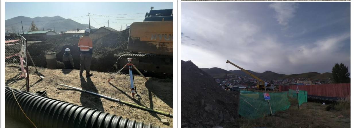
Шугам сүлжээний ажлын явцад хашлага хашаа, тэмдэг тэмдэглэгээг байршуулан ажилласан.
