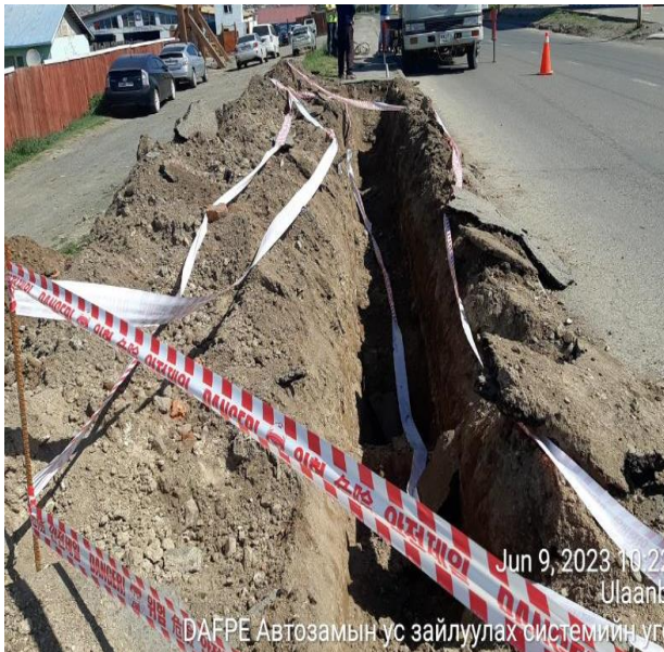
Зураг 7-4. Барилгын газар шорооны ухлагын ажлын үед болон угсарсаны дараах худгийн таг суурилуулахаас өмнө эрсдэлээс хамгаалсан байдал
