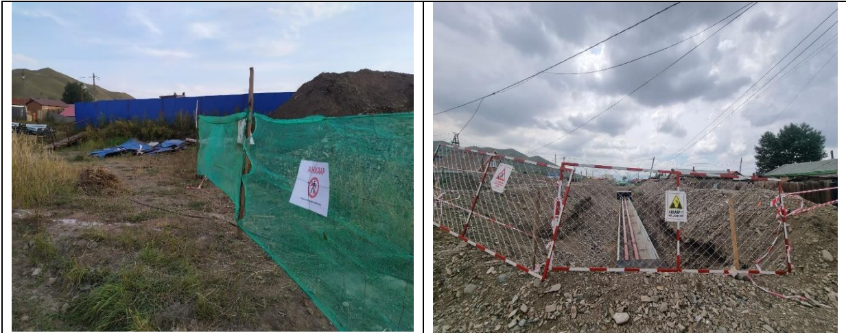
Зураг 7-6. Осол эрсдэлээс хамгаалах хашлага тэмдэг тэмдэглэгээ хийсэн байдал
