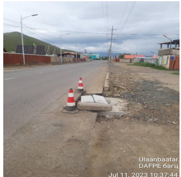
Зураг 7-4. Барилгын газар шорооны ухлагын ажлын үед болон угсарсаны дараах худгийн таг суурилуулахаас өмнө эрсдэлээс хамгаалсан байдал
