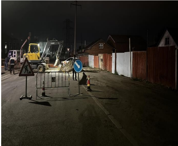
Зураг 7-3. Барилгын угсралт, газар шорооны ажлын үед таних тэмдэг, тэмдэглэгээ, хаалт зэргийг байршуулсан байдал
