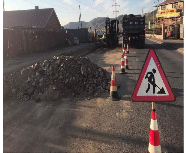
Зураг 7-3. Барилгын угсралт, газар шорооны ажлын үед таних тэмдэг, тэмдэглэгээ, хаалт зэргийг байршуулсан байдал
