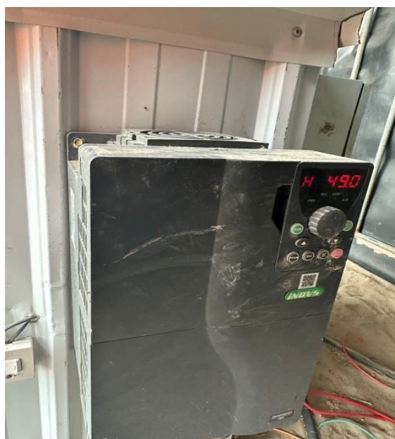
Зураг 7, Ногоон байгууламжийн усалгаанд ашиглах усанд зориулалтын инвертер тавьж хэмнэлт хийж байгаа
