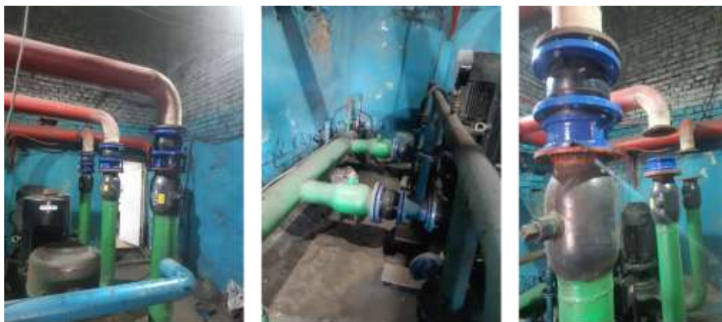
Халаалтын хэсгүүдэд 94 ширхэг хаалт, зөөлөн холбоо, үл буцах клапан суурилуулсан байдал
