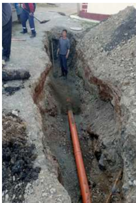
✚ 34-р байрны бохирын 15метр шугам шинэчлэх ажил хийгдсэн
