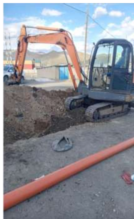
✚ 34-р байрны бохирын 15метр шугам шинэчлэх ажил хийгдсэн
