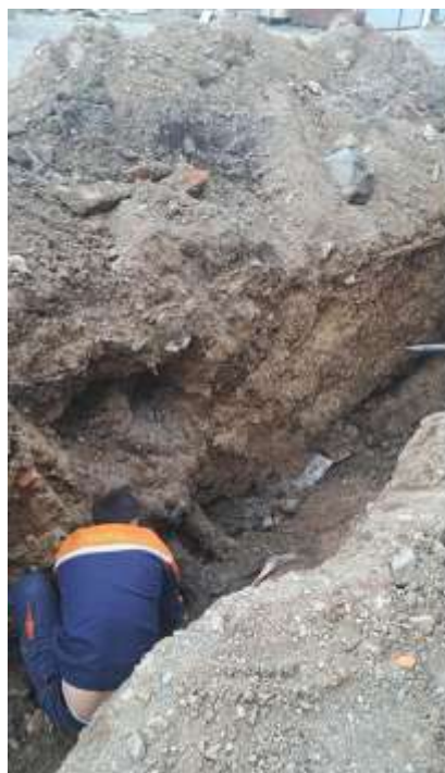
✚ 34-р байрны бохирын 15метр шугам шинэчлэх ажил хийгдсэн
