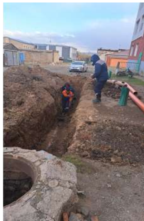
✚ 34-р байрны бохирын 15метр шугам шинэчлэх ажил хийгдсэн
