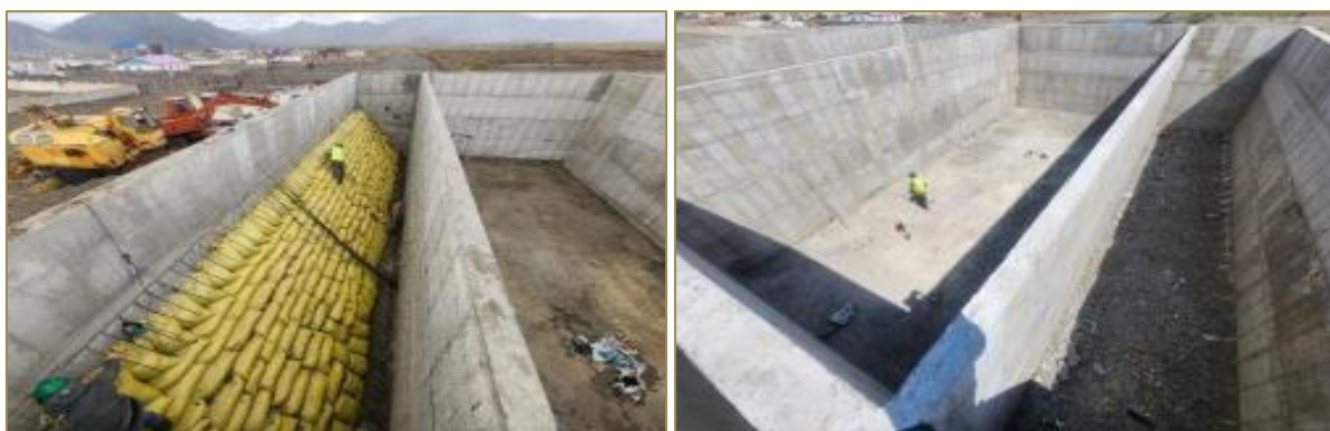
Биологи реакторын барилгын - Х5 тэнхлэгийн налуу ханын арматурын ажил хийсэн байдал
