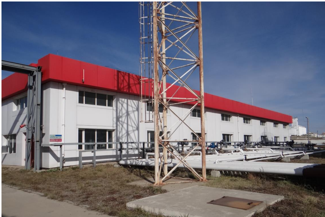
Зураг 2. Вагон насос станцын барилга
