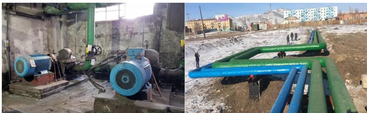
Зураг 9. Сүлжээний насос, Дулааны сүлжээний ил шугамын хэсэг
