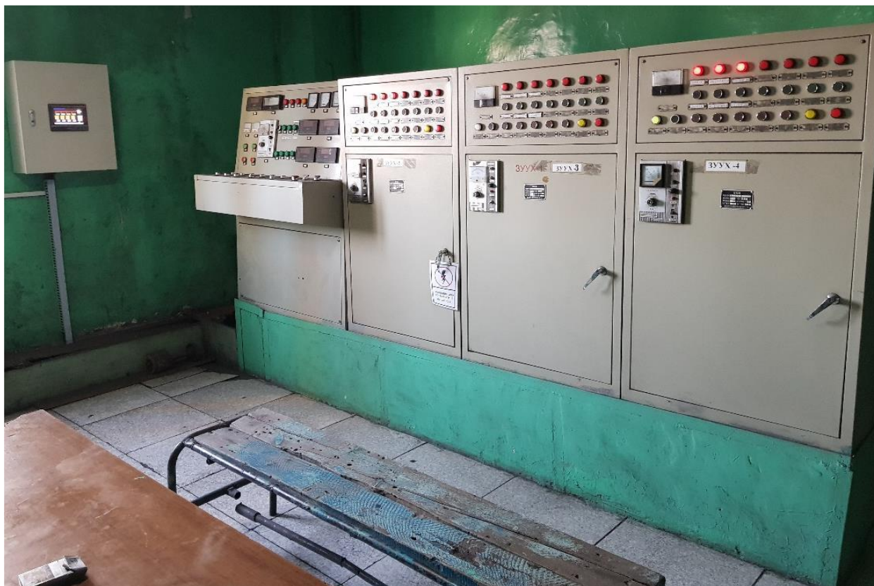
Зураг 7. Дулааны станцын 4 ус халаах зуухны удирдлагын самбар
