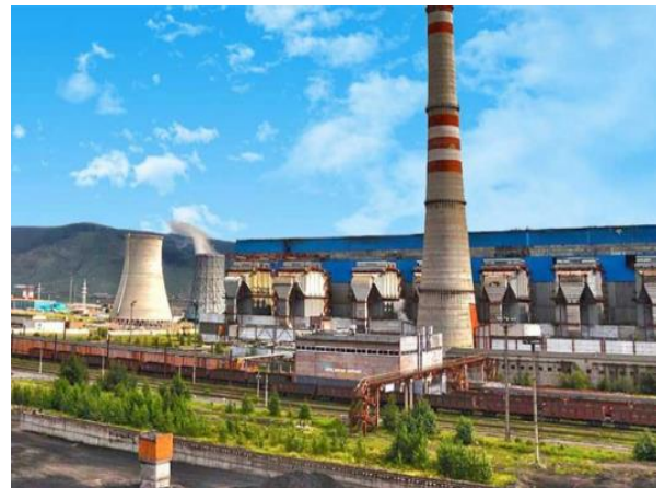
ҮЙЛДВЭРИЙН ЦАХИЛГААН СТАНЦ
