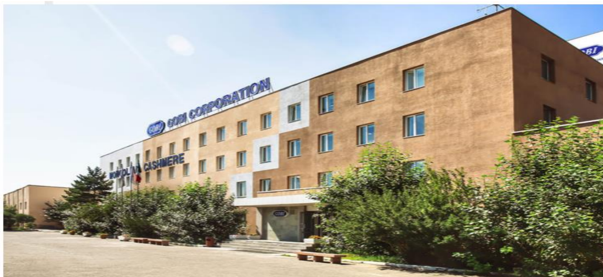
Зураг.2 Говь ХК-ийн үйлдвэрийн байр
