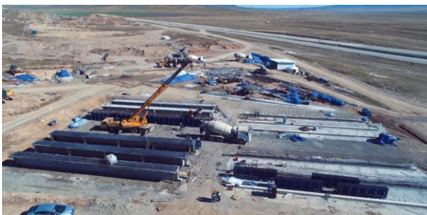
Асфальт, бетоны үйлдвэр
