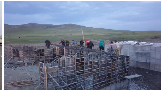
Гүүр хоолой, бетон хашлагын ажлууд
