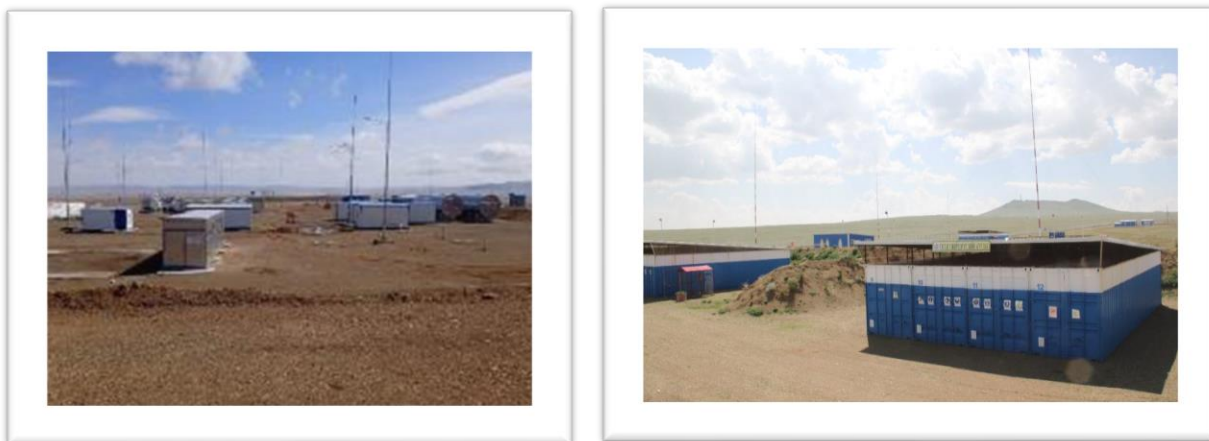
Зураг 12. Үйлдвэр агуулахын цогцолбор харагдах байдал
