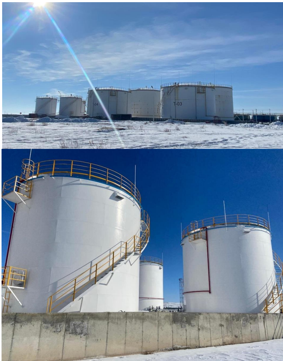
Зураг 3. Газрын тосны бүтээгдэхүүн агуулах босоо савнууд /2022 онд ашиглалтад орсон 700.0м3 багтаамж бүхий 4ш босоо сав/
