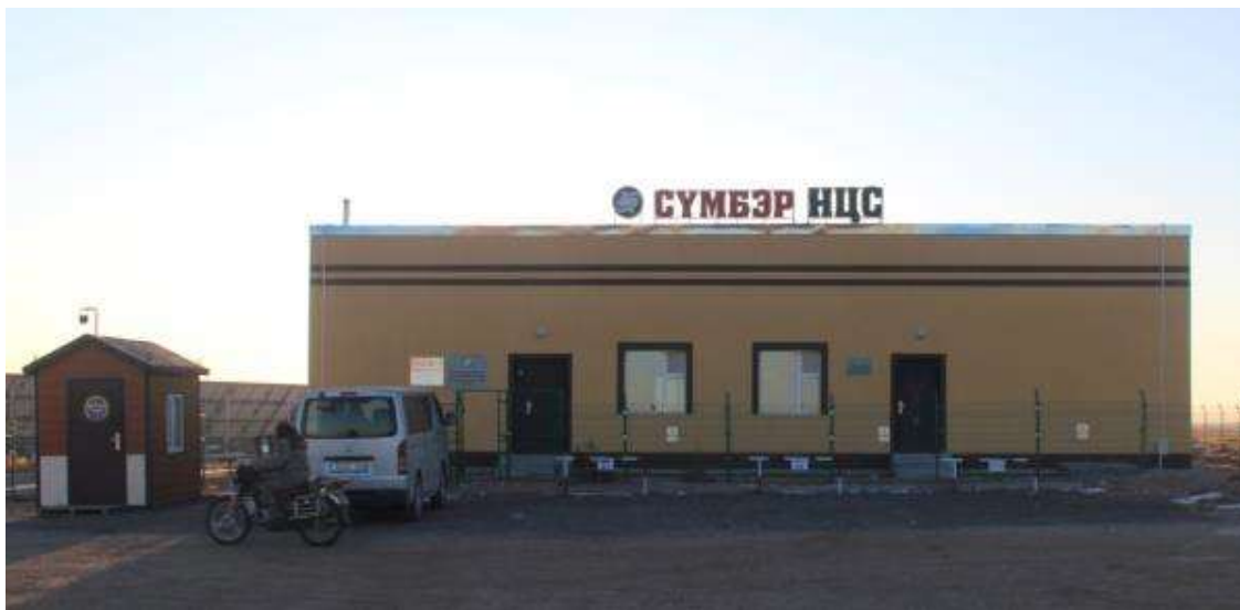
Зураг 2. Үндсэн барилга байгууламж
