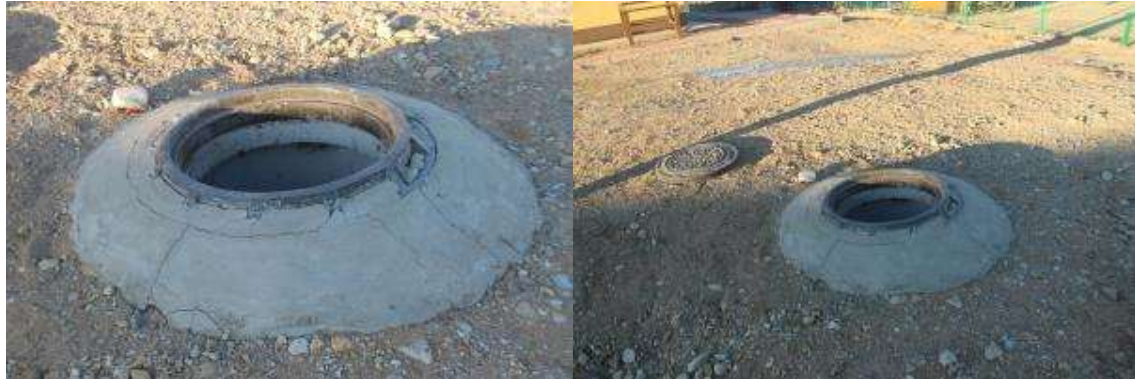
Зураг 15. Бохирын цооног байгуулсан байдал
