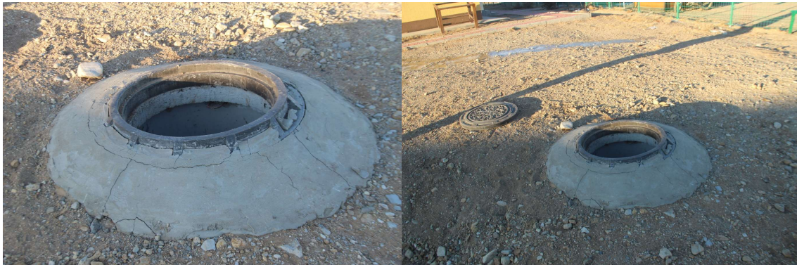
Зураг 18. Бохирын цооног байгуулсан байдал
