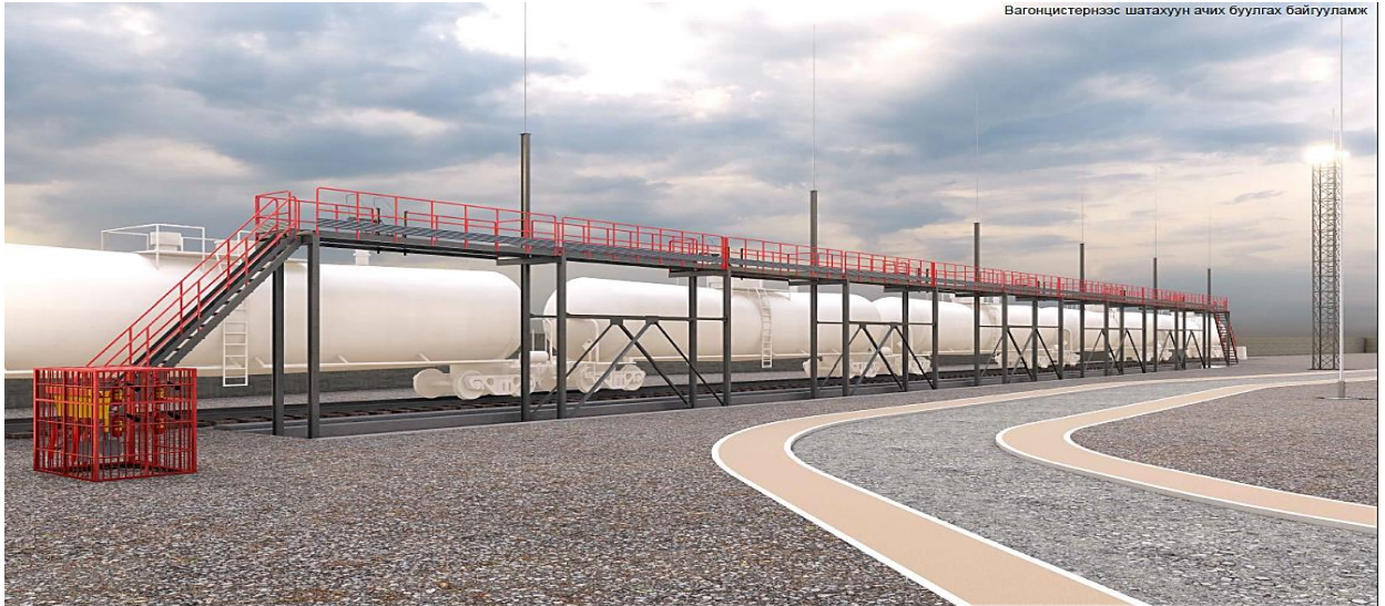
Зураг 4. Вагонцистернээс шатахуун ачих буулгах байгууламж
