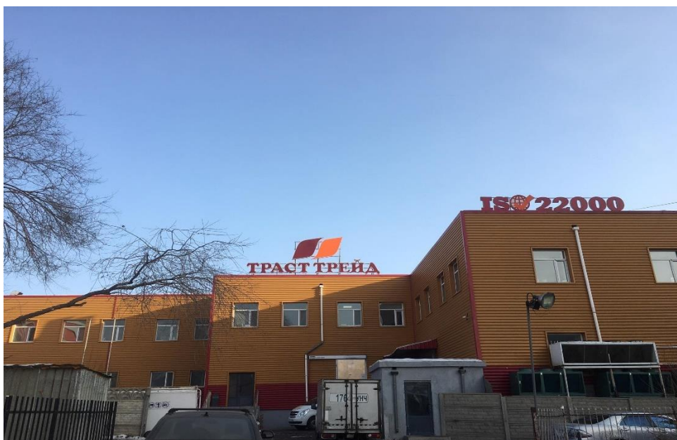
Зураг 3 Үйлдвэрийн гадна байдал
