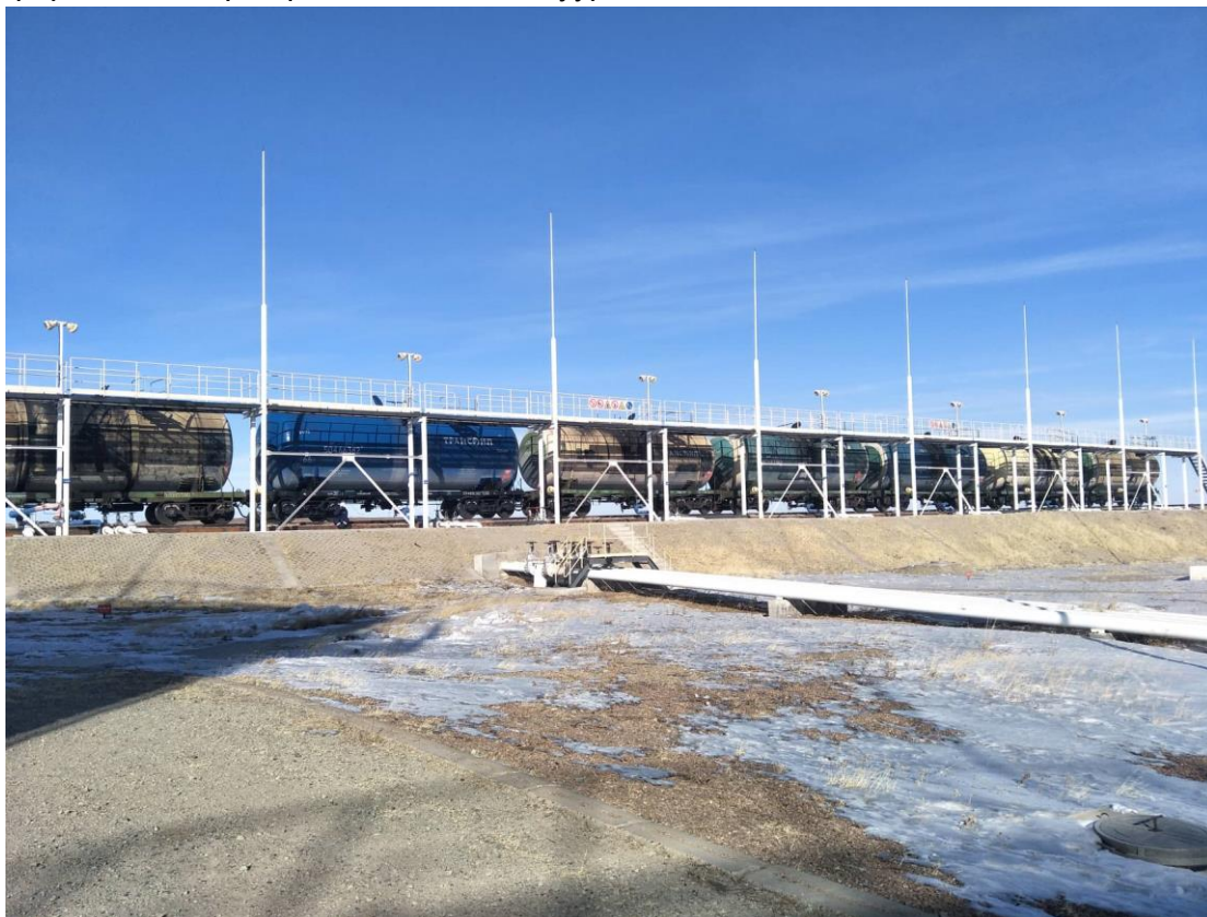
Зураг 3. Вагонцистернээс шатахуун буулгах байгууламж
