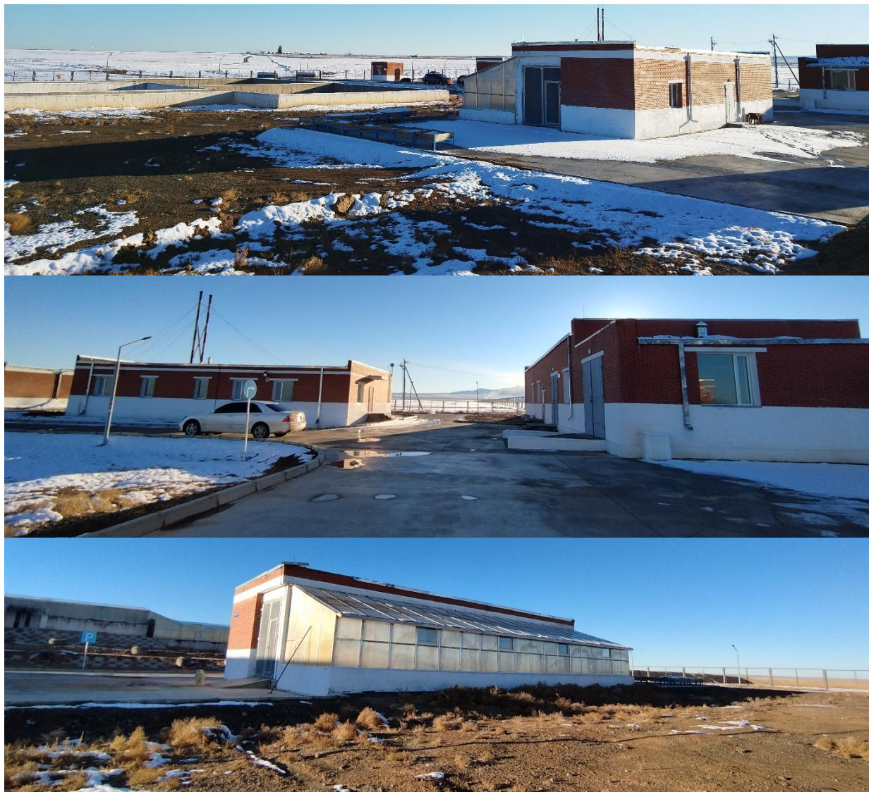
Зураг 27. Шинэ цэвэрлэх байгууламжийн барилга байгууламж фото зураг
