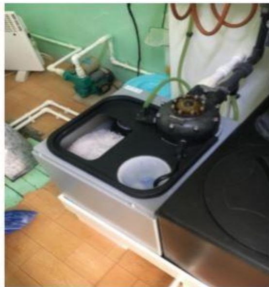
Зураг 13. Гипохлоритын уусмалыг гаргаж авах ClorTec SCT төхөөрөмж
