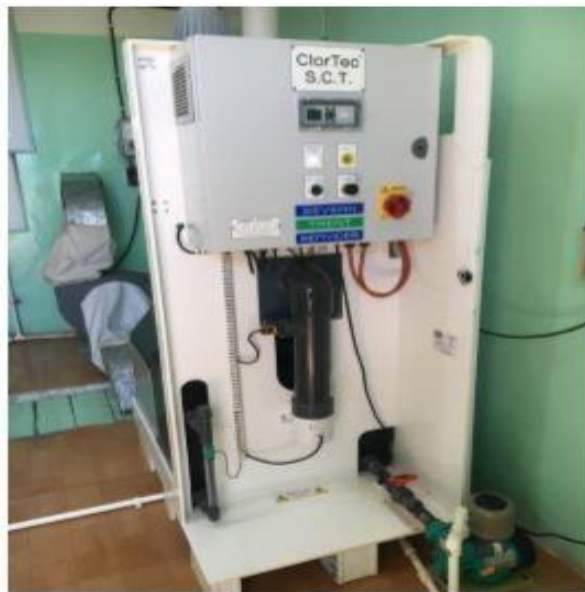
Зураг 13. Гипохлоритын уусмалыг гаргаж авах ClorTec SCT төхөөрөмж
