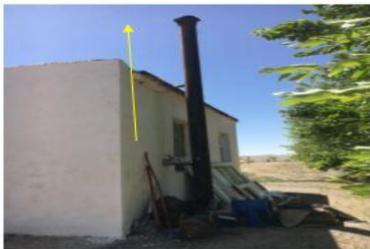
Зураг 18. Электролизийн урвалын үед үүсэх устөрөгчийг механикаар зайлуулах хоолой
