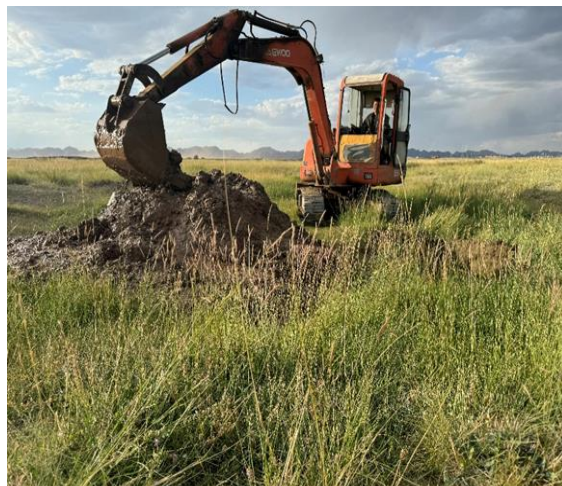
Зураг №223,224 Хуриуутын талбайд бетонон хашилагатай худаг гаргах явц
