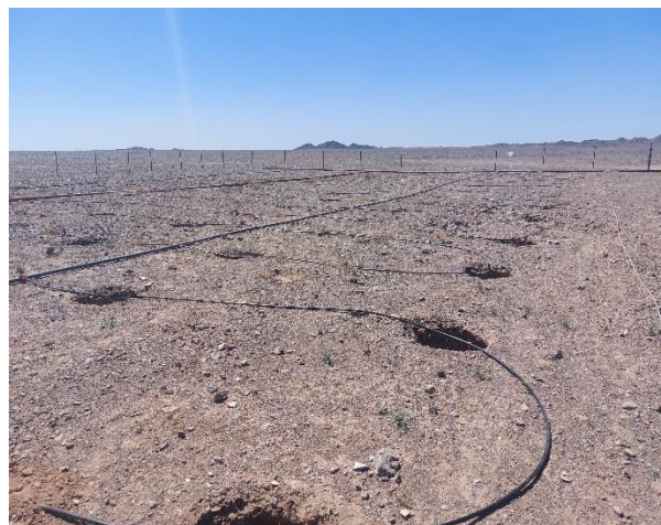
Зураг № 58,59 Заг тарих талбайн усалгааны систем суурилуулах явц хөрс боловсруулалтын явц
