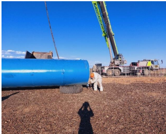
Зураг №118,119 Хуриуутын талбайн усалгааны систем нөөцийн сав байрлуулсан байдал
