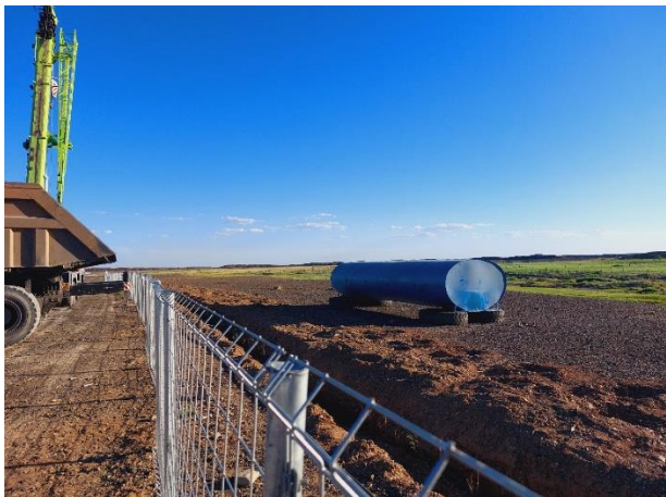
Зураг №220,221 Хуриуутын талбайн усалгааны систем нөөцийн сав байрлуулсан байдал
