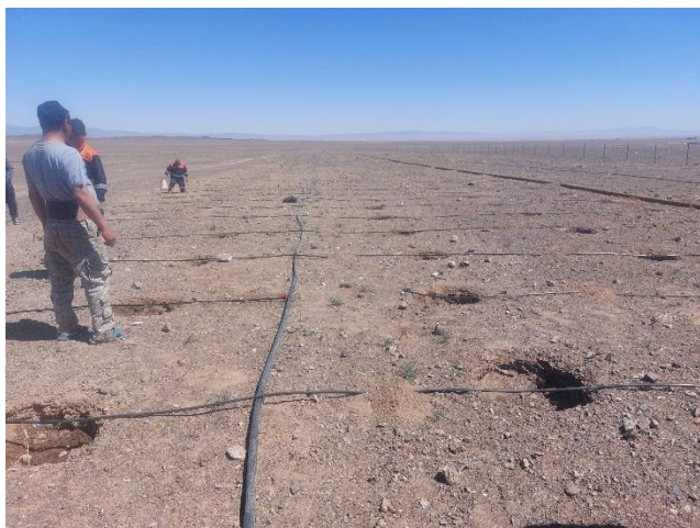
Зураг № 58,59 Заг тарих талбайн усалгааны систем суурилуулах явц хөрс боловсруулалтын явц
