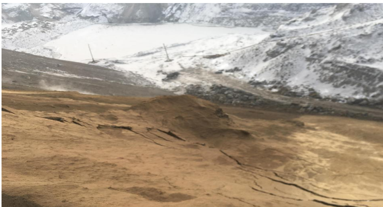
Зураг 5. Шаталт үүссэн талбайг хөрсөөр хучилт хийж унтраасан байдал
