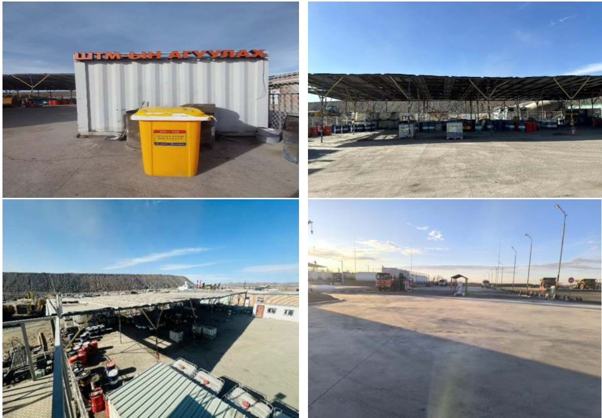
Зураг 26. Уурхайн ШТС, тосны агуулах
