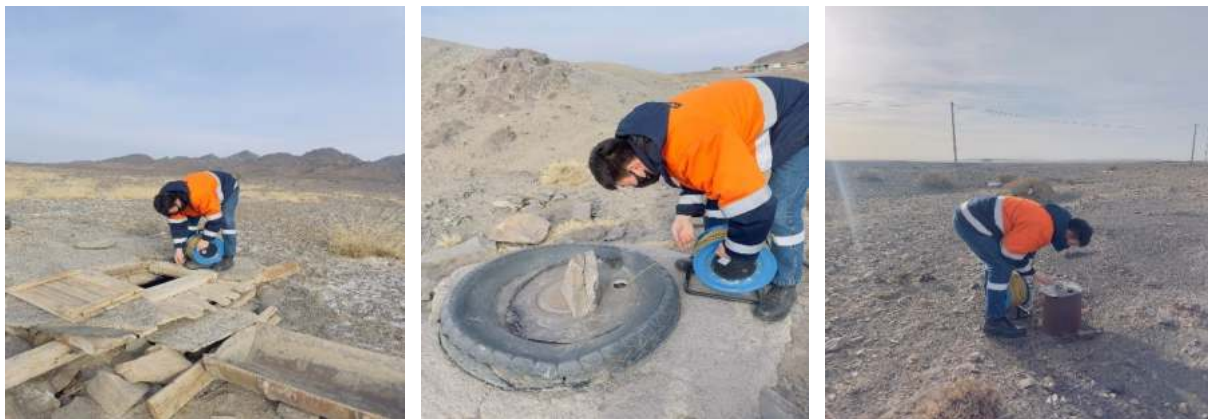
Зураг 56. Цооногт хэмжилт хийж байгаа байдал
