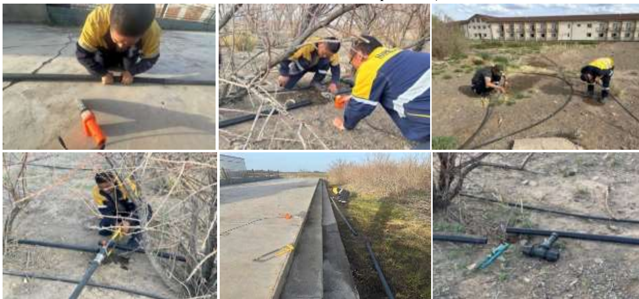
Усалгааны систем засварлах явц
