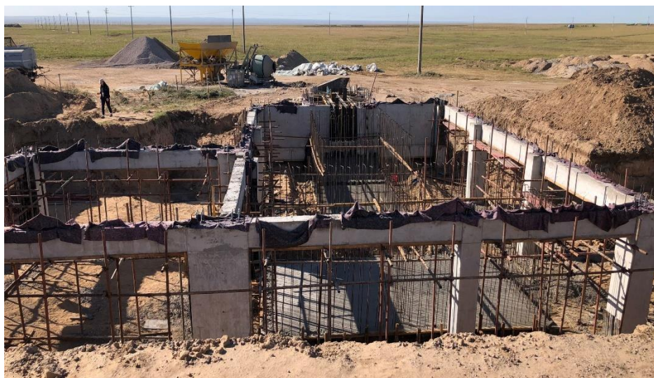
Зураг № 56. Шинэ ахуйн бохир цэвэршүүлэх байгууламжын барилгын ажлын явц
