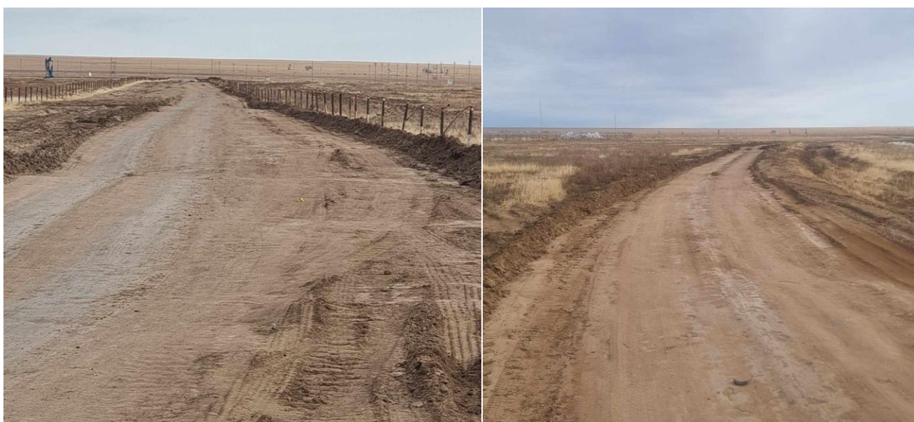
Зураг № 13. Автогрейдерээр хусаж тэгшилсэн зам.
