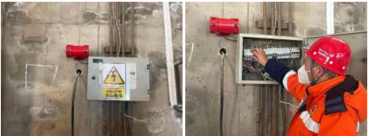
Зураг 64. Дуут дохиоллын систем суурилуулсан нь
