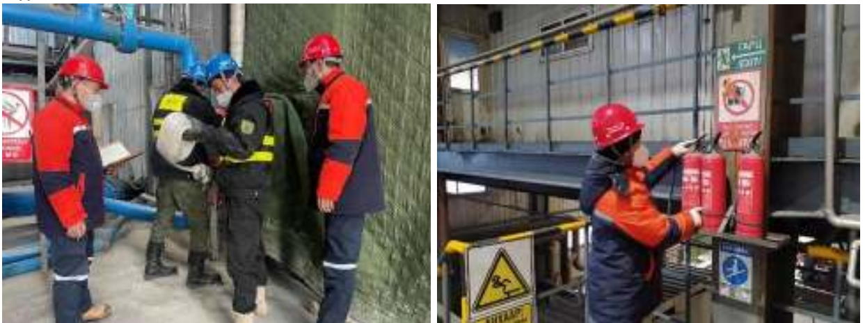
Зураг 36. Галын хор болон гал унтраах багаж хэрэгслийг шалгаж байна
