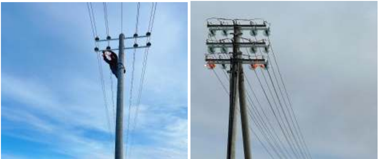
Зураг 60. Шувуу үргээгч толь суурилуулж буй нь
