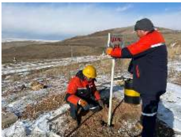
Зураг 2.2.2.1в. Хаягдлын далангийн хяналтын цооногийн пайзыг шинэчилж буй нь
