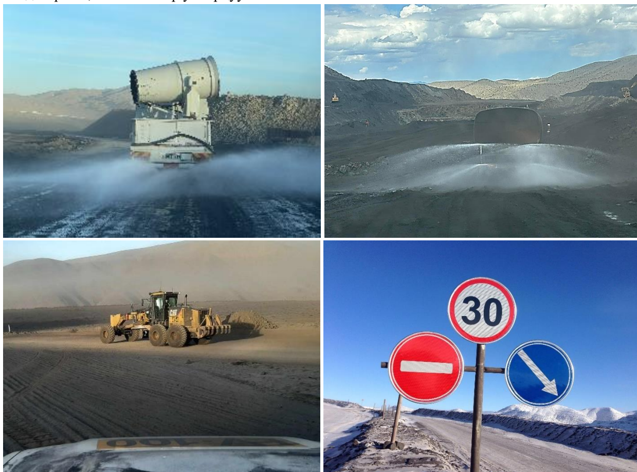
Зураг 8. Уурхайн гадна болон дотор замын усалгаа, тэмдэг тэмдэглэгээ, замын засвар арчилгаа хийж буй байдал
