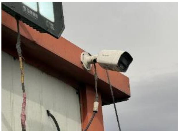
Зураг 6. Худагт суурилуулсан ус ашиглалтын хяналтын камер
