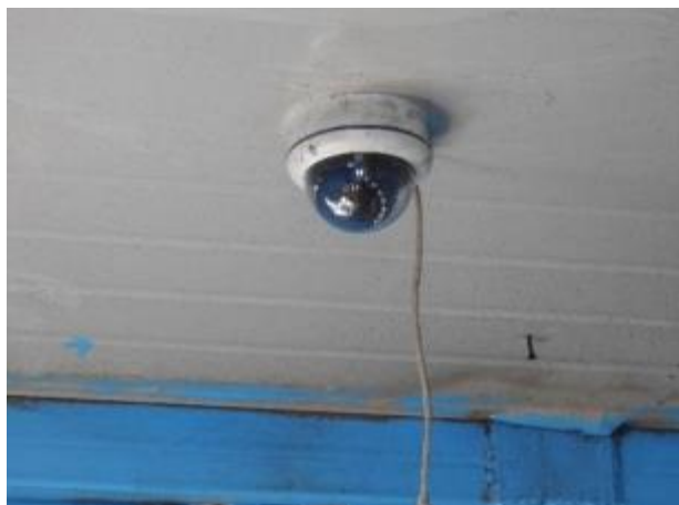
Зураг 6. Худагт суурилуулсан ус ашиглалтын хяналтын камер
