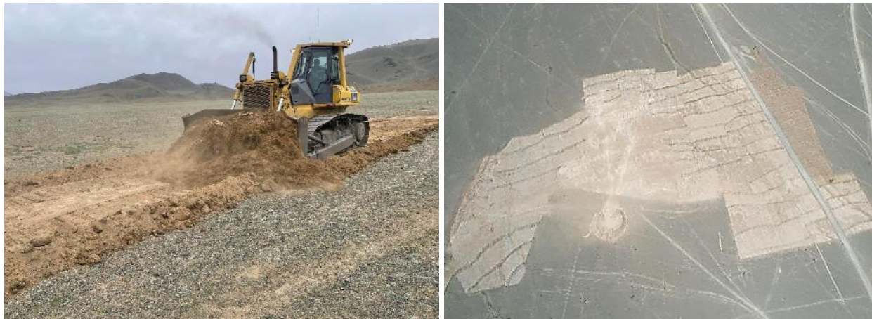
Зураг 13. Хуулсан шимт хөрс тээвэрлэлт
