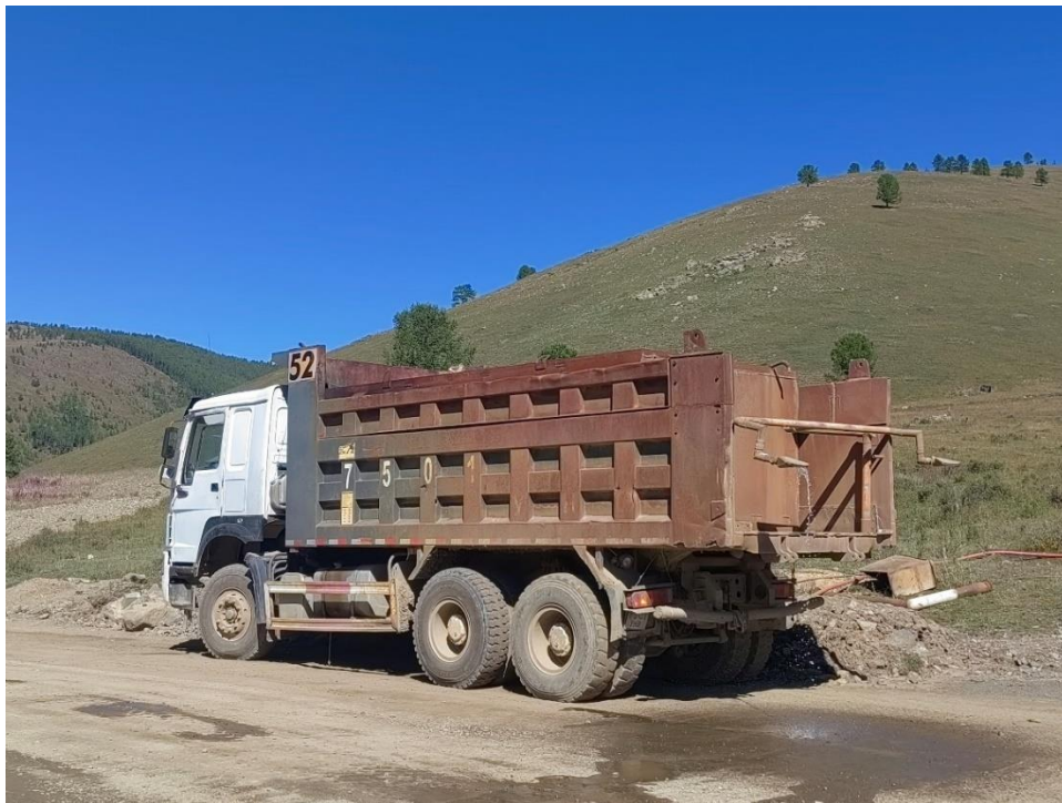
Зураг № 5 Зам усалгааны ажил хийгдэж буй байдал
